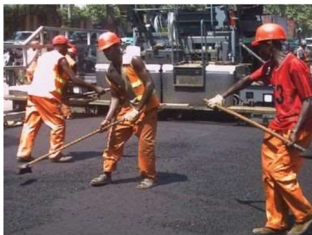
Réhabilitation des routes
