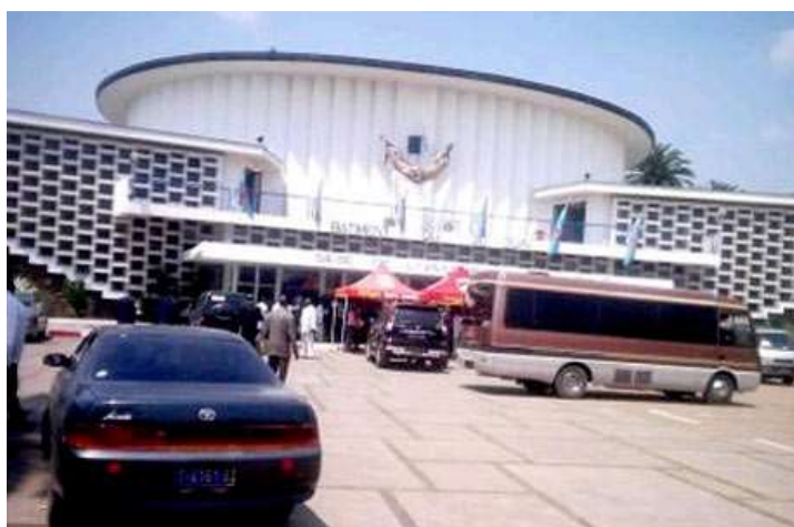
Vue de l'extérieur de l'Assemblée Provinciale
